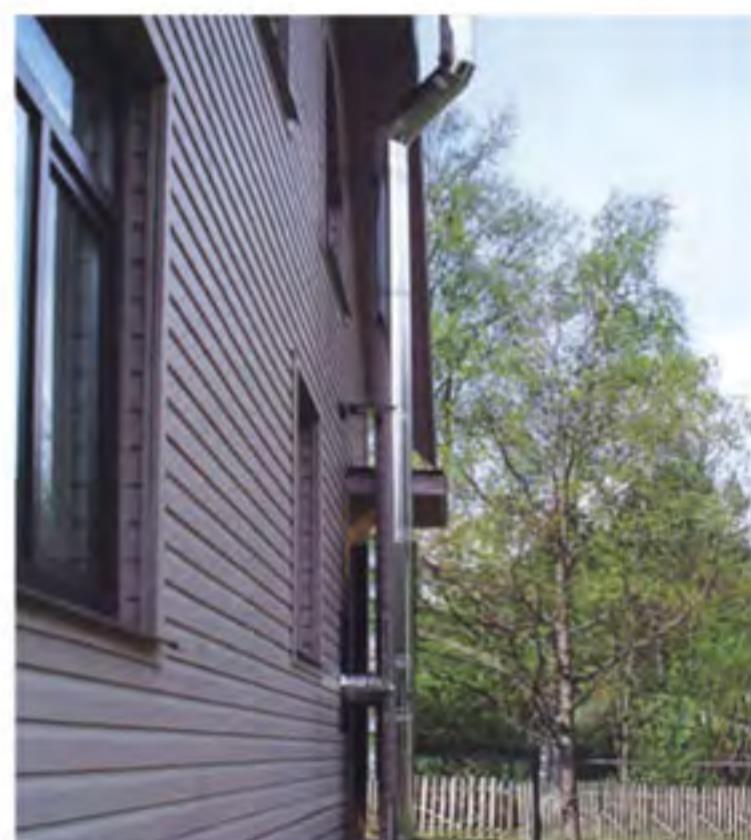
Частный дом. Зеленогорск трубы \varnothing 130/230
