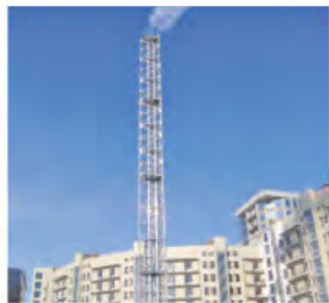
Коллективная котельная Высотой 48 м. трубы \varnothing 600/700
