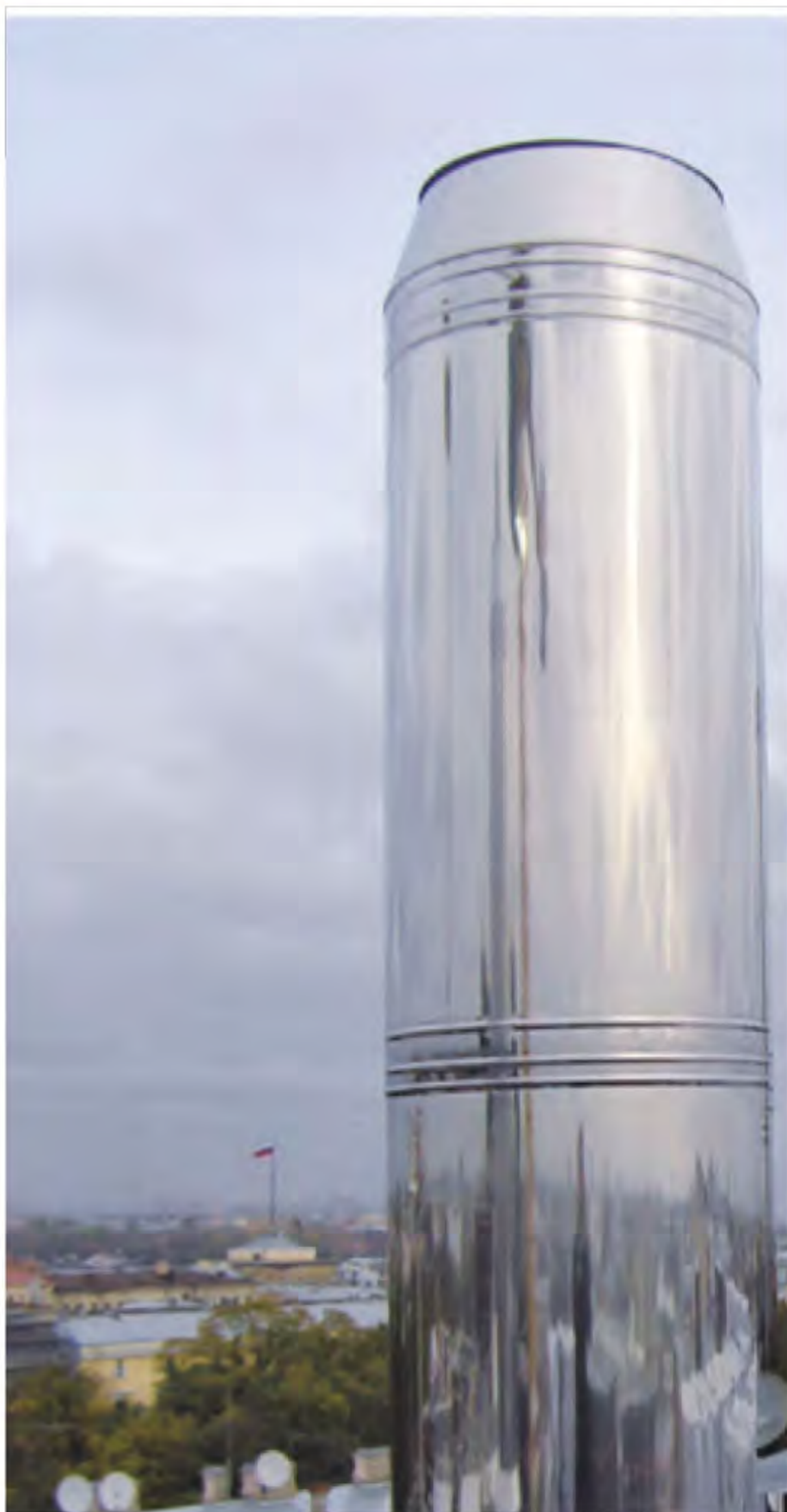
Арка Генерального штаба Два дымохода трубы \varnothing 500/600
