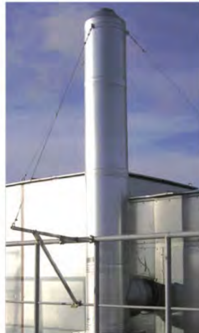
Завод по производству японских автомобилей NISSAN в пос. Каменка трубы \varnothing 100/200 \varnothing 200/300 \varnothing 250/350 \varnothing 300/400
